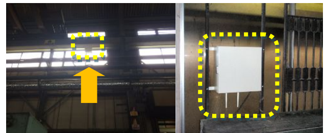
図11 工場側ルーター設置
